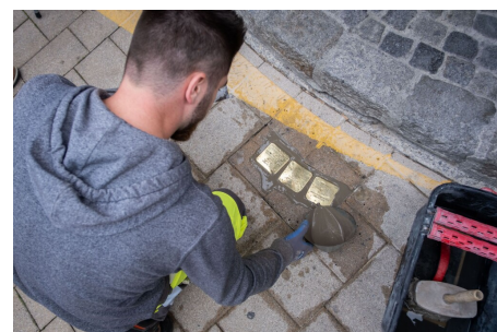
Stolpersteinverlegung für die Familie Weiss am 22.10.2021 ©Alexander Danner
